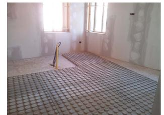
BETON RADIANT È IL SISTEMA IDEALE PER LA REALIZZAZIONE DI MASSETTI A SECCO, GARANTENDO UN'OTTIMA FACILITÀ DI POSA IN OPERA PER SISTEMI DI RISCALDAMENTO RADIANTE.
